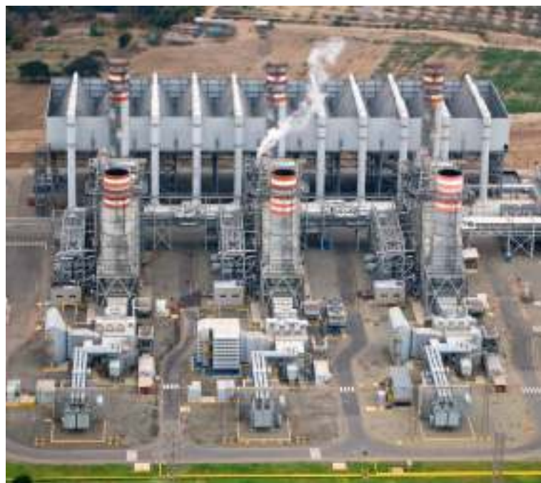
© Kallpa Generación S.A.
